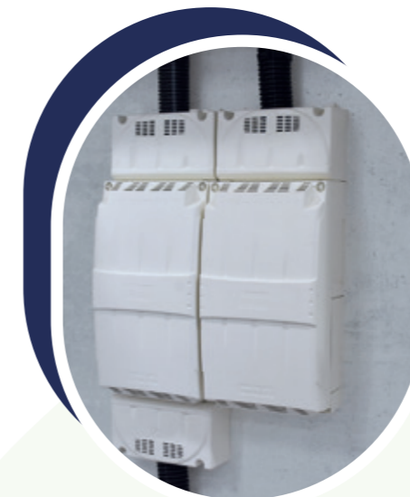
SPCM placés dans un parking comportant 2 travées
