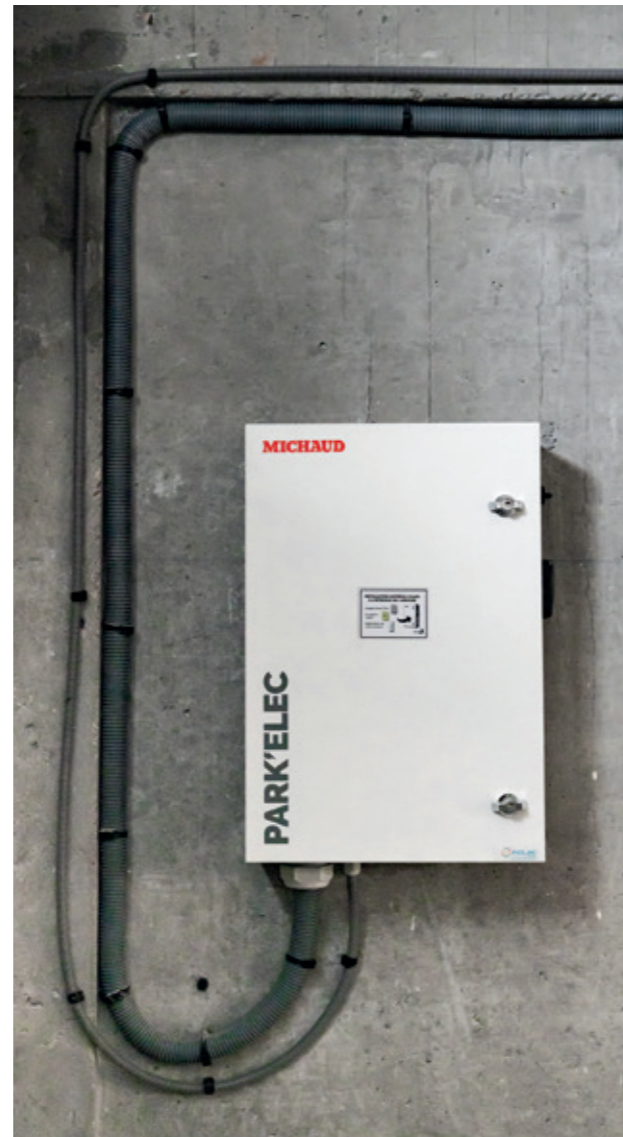
Exemple d'armoire de recharge "tout en un"
