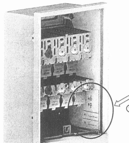
1 – Identifier le raccordement à l'aide de l'étiquette fournie sur le côté droit à l'intérieur de la borne. Effectuer le marquage à l'aide d'un stylo feutre à encre indélébile.
